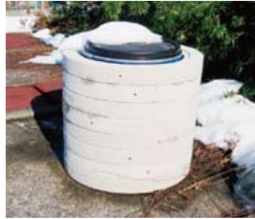
▲廃棄物地上保管用ドラム管
